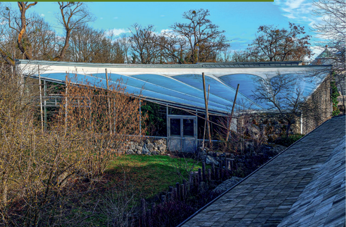
Saniertes Dach des Schildkrötenhauses
